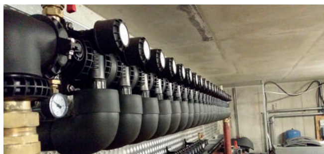
Фотография показывает 27-контурный коллектор ProCalida GT3 в системе грунтового теплообменника теплового насоса. Система находится в торговом центре Huta в местечке Węgierska Górkа (Южная Польша).
