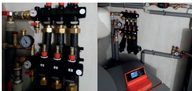
Фотографии показывают 3-контурный коллектор ProCalida IN в системе теплового насоса. Система находится в коттедже в местечке Turza Śląska (Южная Польша).
