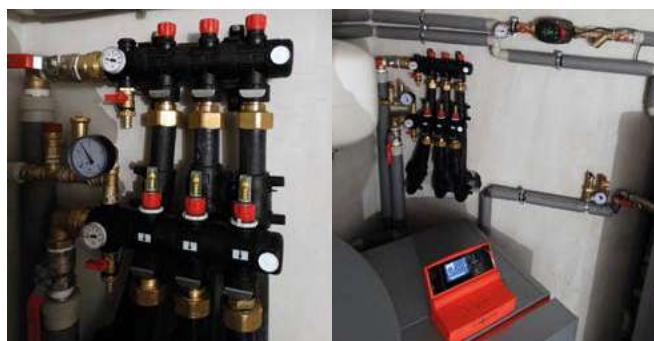
Фотографии показывают коллектор ProCalida IN 3-контурный в системе теплового насоса. Система находится в коттедже в местечке Turza Śląska (Южная Польша).
