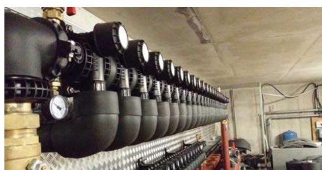
Фотография показывает коллектор ProCalida GT3 27-контурный в системе грунтового теплообменника теплого насоса. Система находится в торговом центре Huta в местечке Węgierska Góra (Южная Польша).
